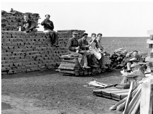
Frokostpause på Svejbæk Bøjlefabrik
