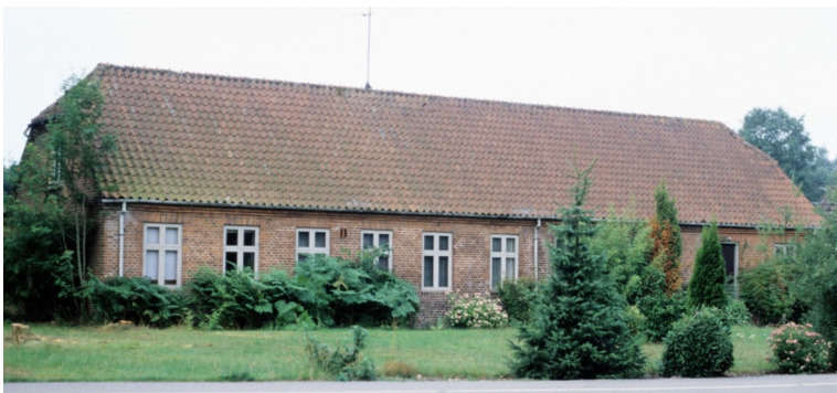
Den gamle skolebygning - nordsiden ud mod Julsøvej - fotograferet kort før nedrivningen.
