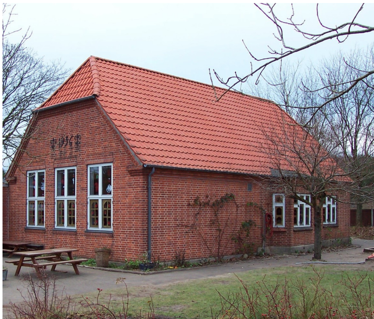
Forskolen lå i denne bygning, som i dag rummer børnehaven Tyttebærhuset.
