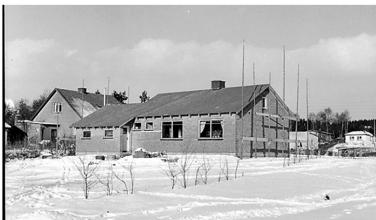
Hus på Julsøvej under opførelse – ca. 1956
