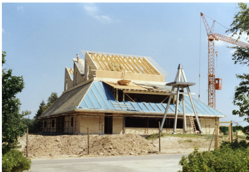
Kirken under opførelse
