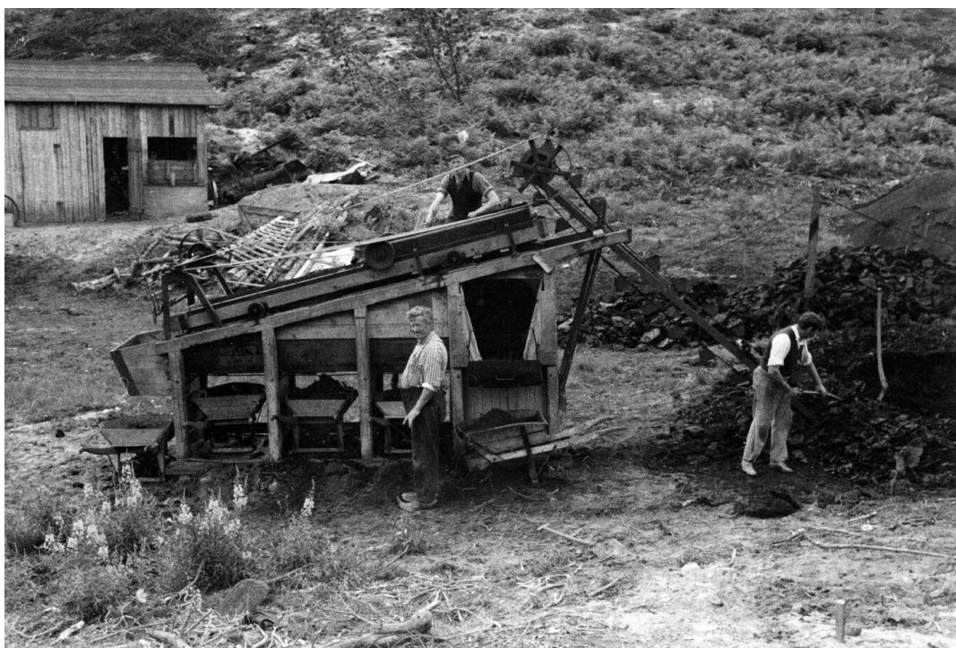
Fra brunkulslejet Borgdalsvej 5. Sorteringsanlæg og transportbånd.
